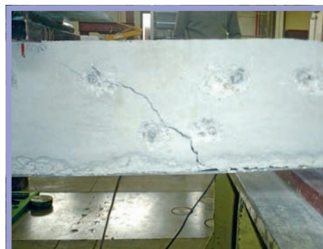
Figura 8: fessurazioni a rottura per taglio
