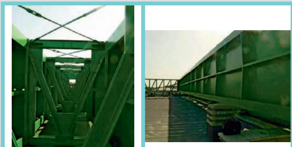
Figure 5-6: Corpo E_New – Particolari travi alte di copertura
